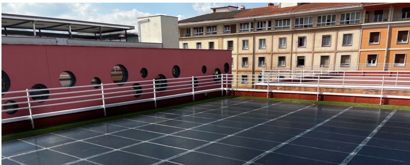
Ilustración 1: Instalación suelo fotovoltaico Bilbao
