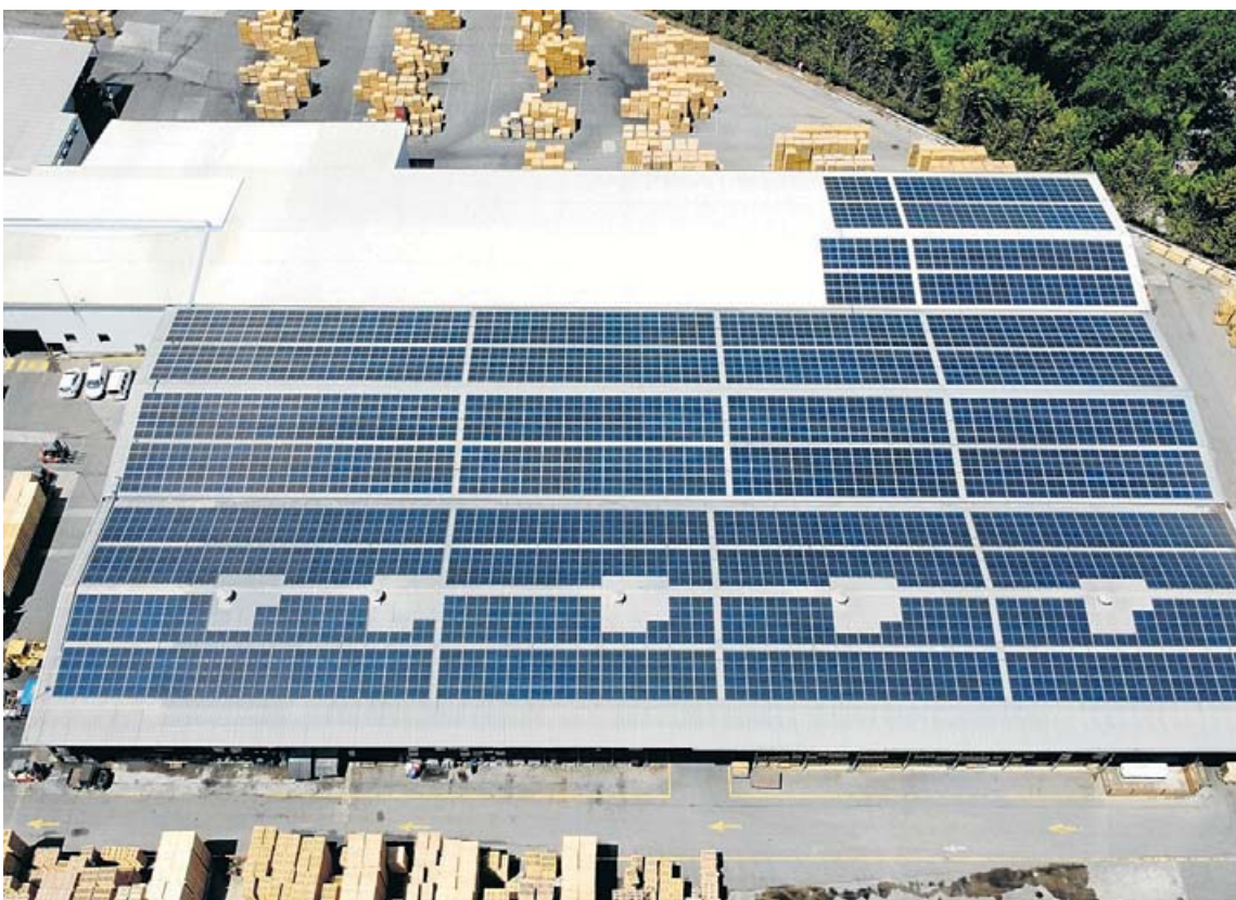
Instal·lació de plaques solars per a autoconsum industrial. ESTABANELL INNOVER
