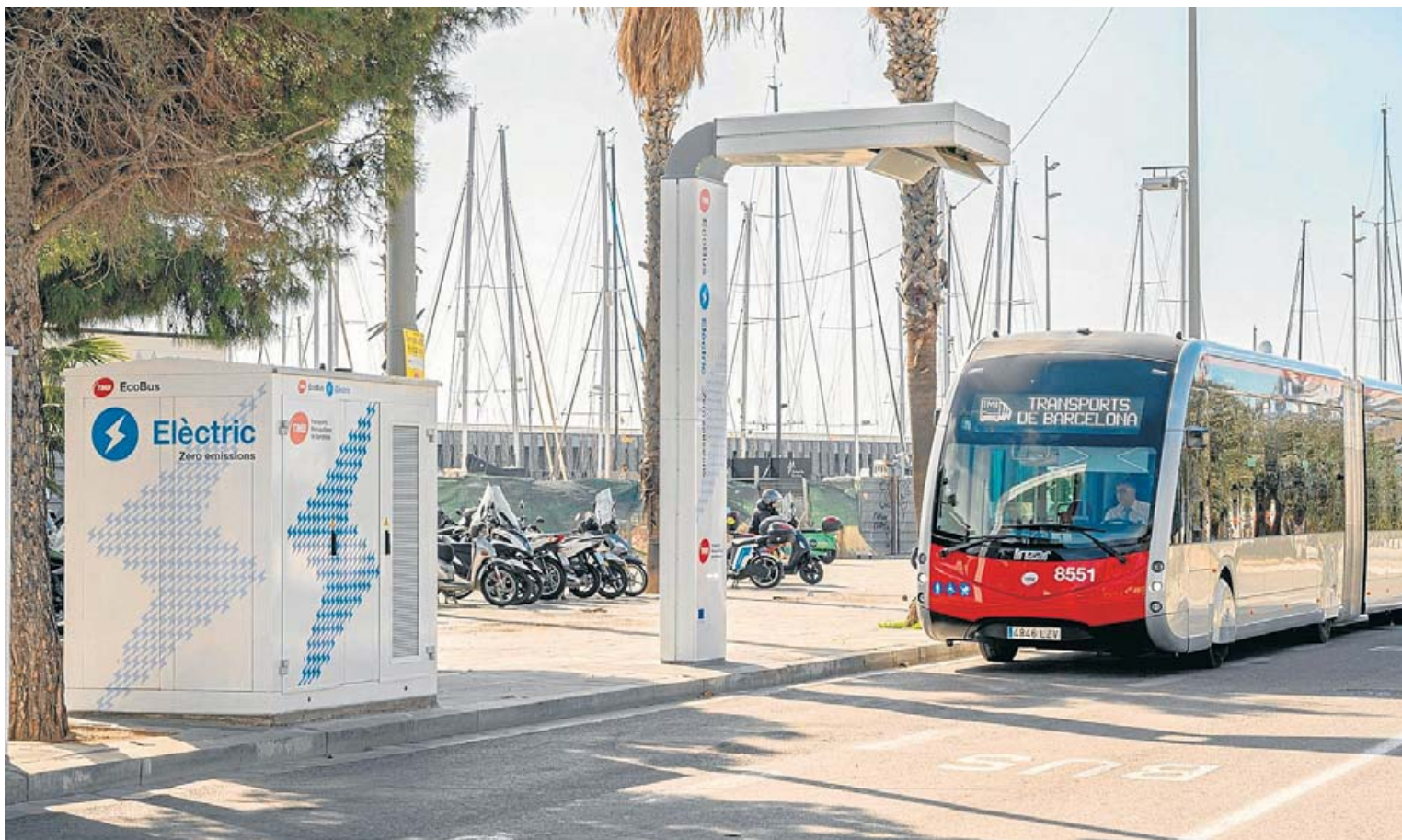
Imatge d'un dels pantògrafs instal·lats per Endesa a Barcelona, que permeten la recàrrega d'autobusos elèctrics de TMB. ENDESA
